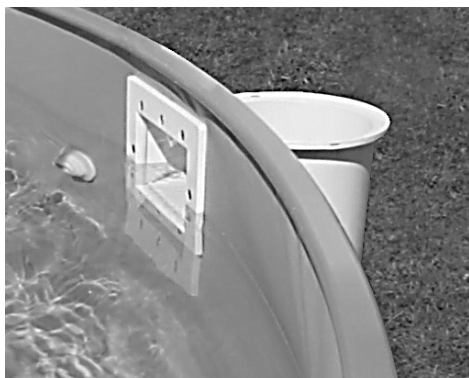
Zdj. 1 - skimmer zamontowany w ścianie asenu Zdj. 2 - skimmer zamocowany na ścianie basenu
